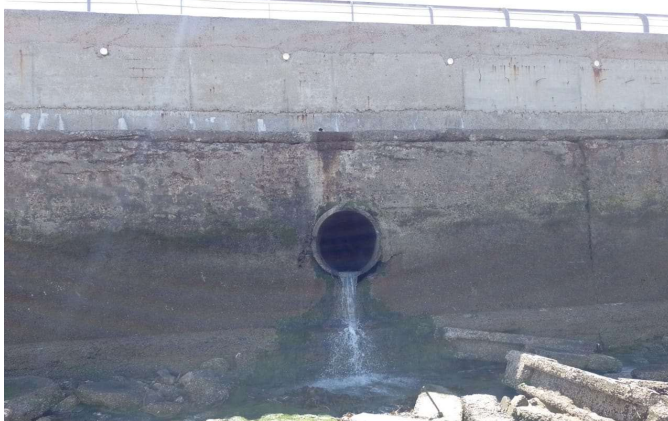
Av. Ducos – Desagües pluviales en muro vertical
