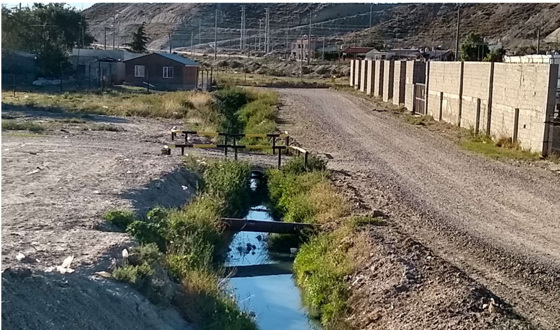
Canal en conducto cerrado actual
