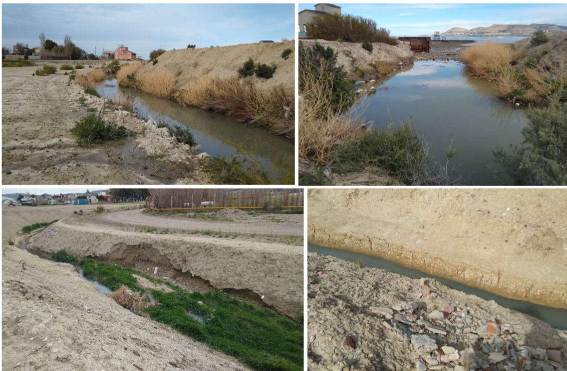
Fotos del cauce de agua
