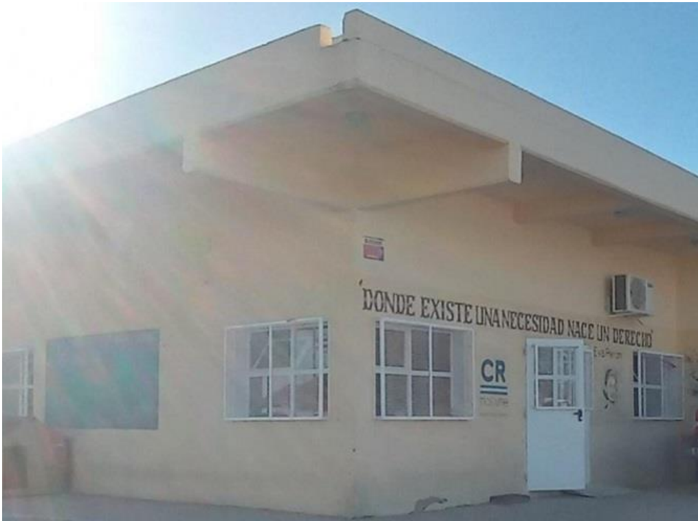
(Foto 1: Frente de la institución donde se encuentra el ingreso a la misma).
