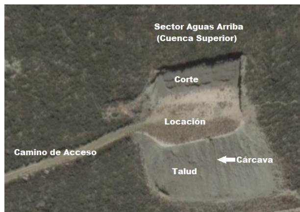
Imagen 4: Ejemplo típico de locación petrolera sobre un faldeo y acceso a la misma.
