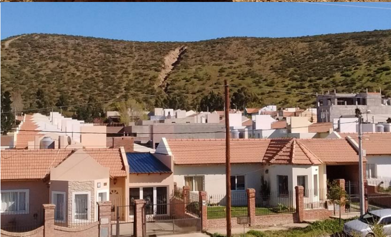
Cárcava en el faldeo Oeste del cerro del Mirador en Rada Tilly.
