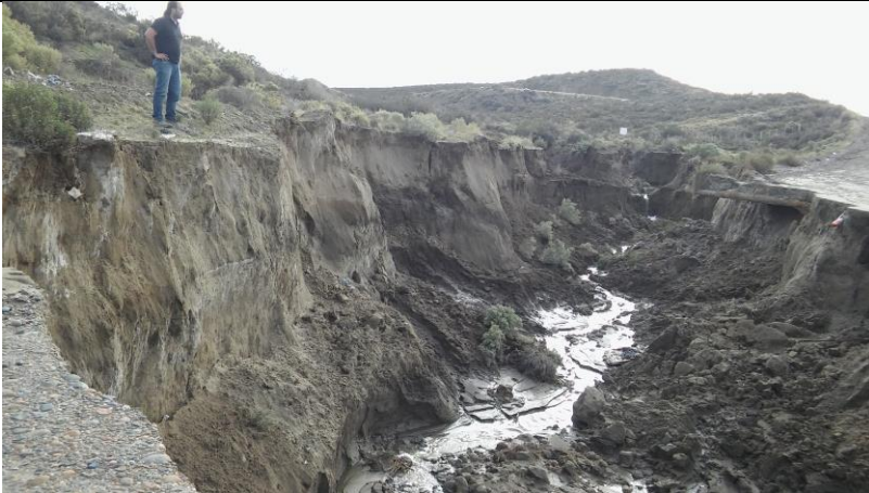
Cárcava sobre camino que circunvala en el sector Oeste la Ciudad próximo a la Fracción 14.
