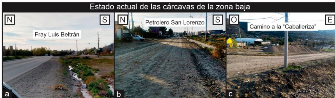
Figura 47. a) Relleno y asfalto de la cárcava de la avenida Fray Luis Beltrán. b) Relleno de la cárcava de la calle Petrolero San Lorenzo. c) Relleno de la cárcava del camino a la “Caballeriza”.
