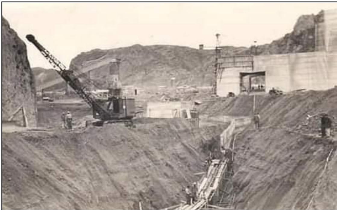
Figura.4: Construcción del dique Florentino Ameghino, año 1957.
