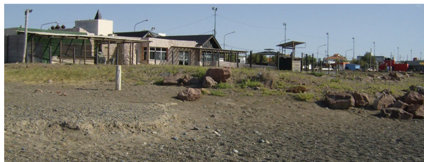
Figura 17: a la izquierda puede observarse un escarpe de erosión (arreglo 10A) junto a la obra de protección del parador "La Brava" (arreglos 5G, 9A y 9B).
