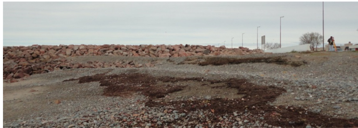
Figura 23: arreglos 12A (espigón), arreglo 7F(2012) (escarpe de erosión marina) (Foto: agosto 2013)
