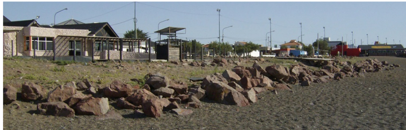
Figura 16: en primer plano se observa una obra de protección perimetral; detrás se observa el parador "La Brava", arreglos 5G, 9A y 9B.
