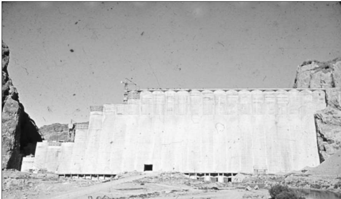
Figura 7: Obra en construcción del Dique Florentino Ameghino.
