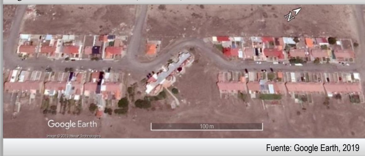
Figura N° 31: Barrio Médanos (vista aérea)
