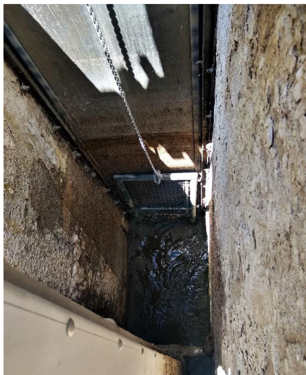
Foto 2: Desbaste grueso. Estación Vucetich.
