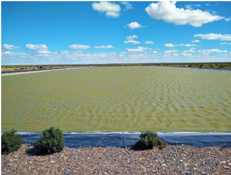
Foto 16: Laguna de maduración. Sistema lagunar Rawson.
