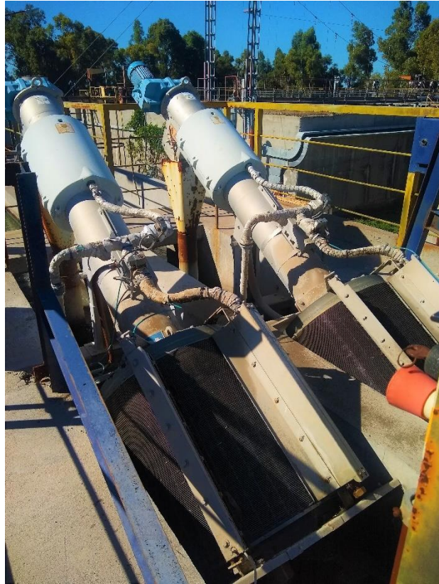
Figura 5: Tamices rotativos. Sistema preliminar.
