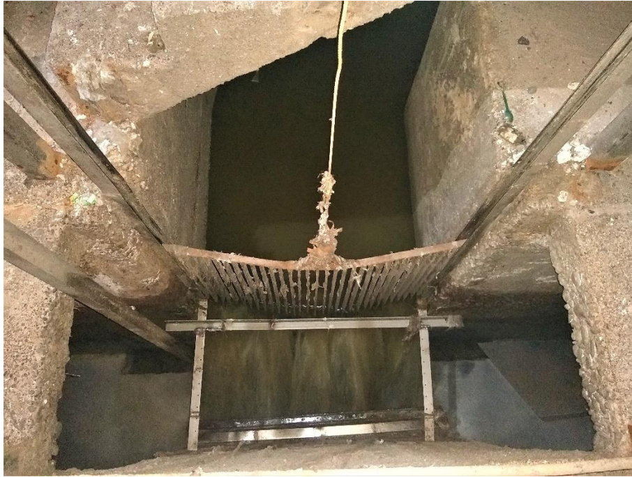
Foto 3: Desbaste grueso. Estación Vucetich.
