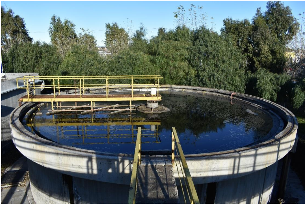
Figura 11: Sedimentador secundario.
