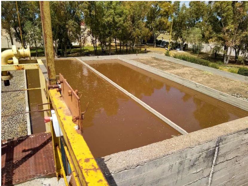
Foto 8: Lechos o playones de secado. Planta.
