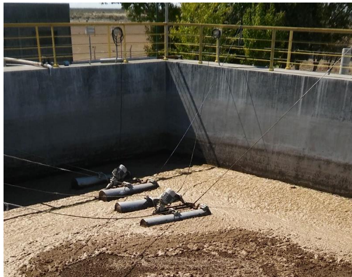
Figura 16: Digestor aeróbico.
