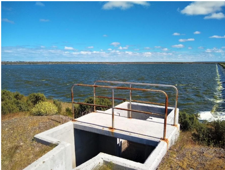
Foto 12: Cámara de ingreso de afluente a sistema lagunar Rawson.
