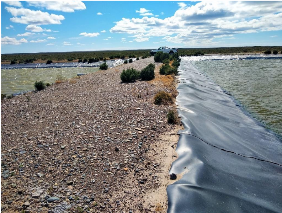
Foto 15: A la derecha la laguna facultativa, a la izquierda la laguna de maduración. Sistema lagunar Rawson.
